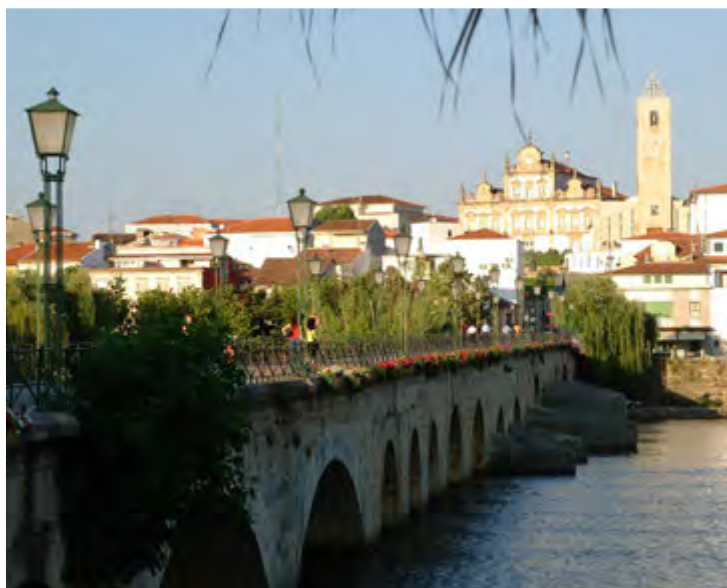
Ponte Velha. Mirandela.
