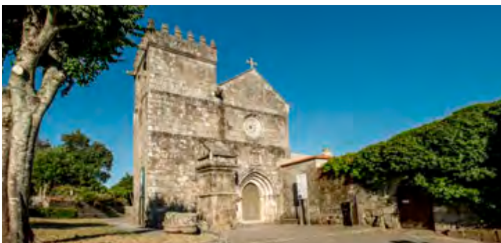
Mosteiro de São Pedro de Cete. Paredes.
