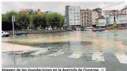
Imagen de las inundaciones en la Avenida de Ourense. DP
