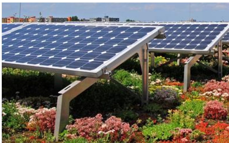
Paneles fotovoltaicos integrados en el tejado verde (energía solar)
