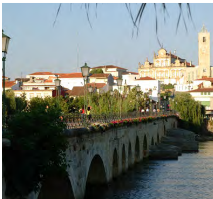
Ponte Velha. Mirandela.
