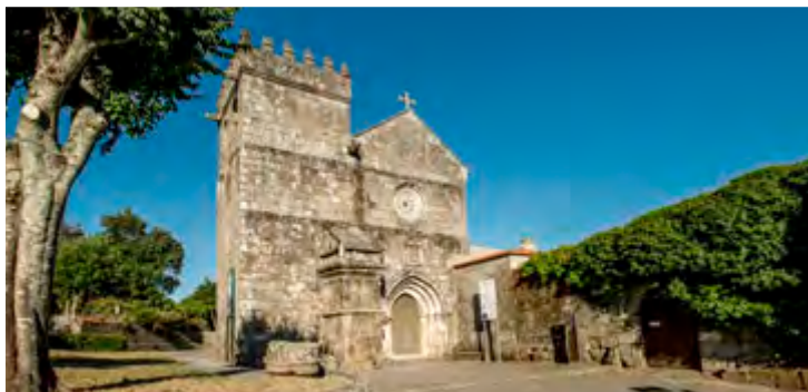
Monasterio de São Pedro de Cete. Paredes.
