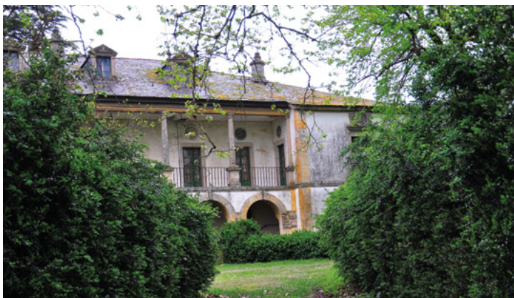
Paço de Bóveda (Monforte de Lemos)
