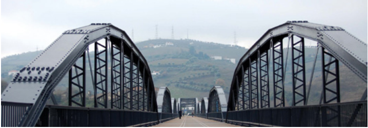
Ponte metálica (Peso da Régua)
