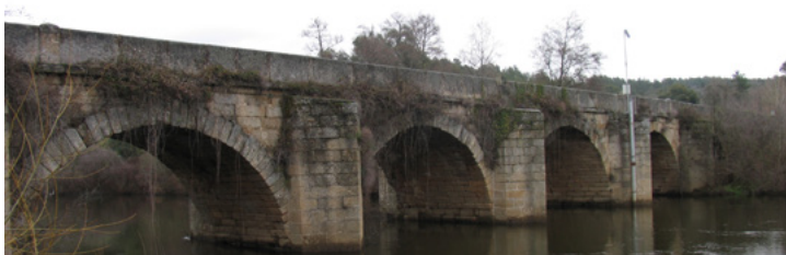
Ponte sobre o Tua (Mirandela)
