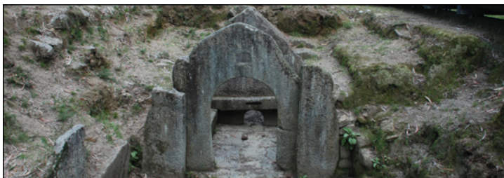
Estrutura termal Pena Grande (Barcelos)
