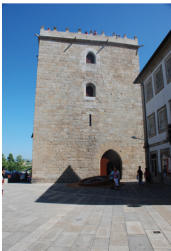
Torre da Porta Nova (Barcelos)
