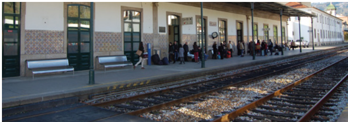
Estación de tren (Peso da Régua)
