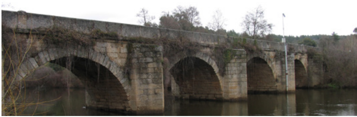
Puente sobre el Tua (Mirandela)
