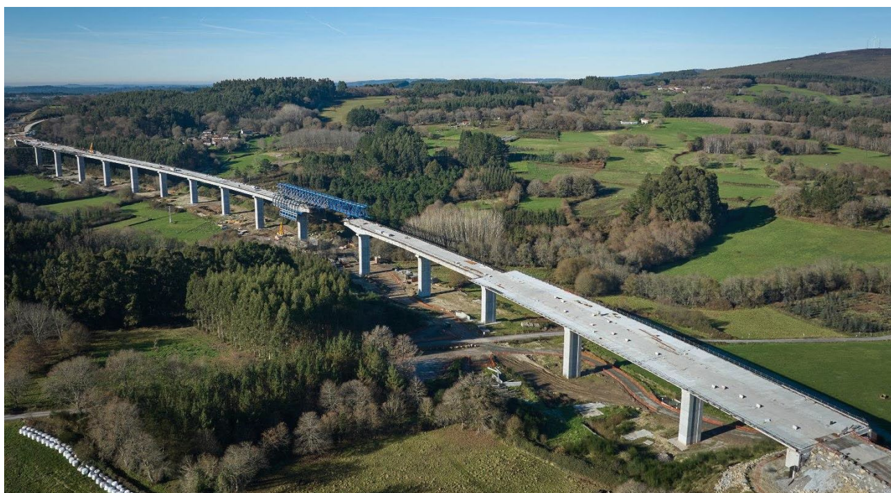
Viaduto sobre o río Pambre, tramo Melide-Palas de Rei, de 977 metros de lonxitude. (ACCIONA).
