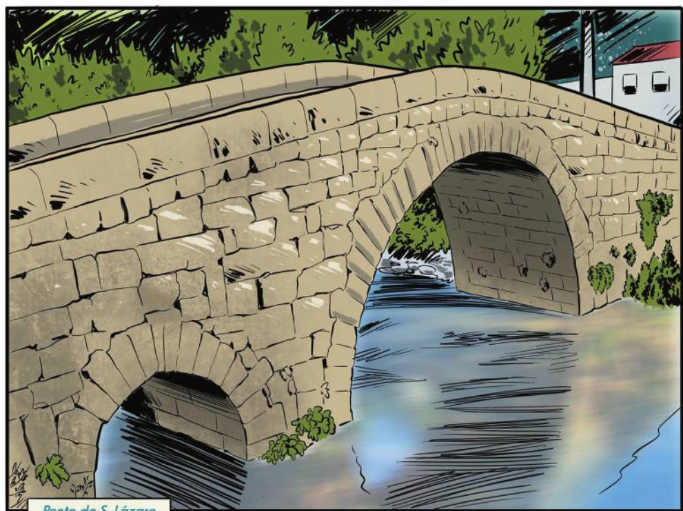
Ponte de S. Lázaro
