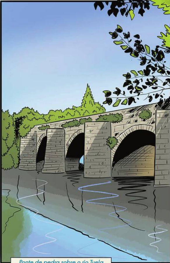
Ponte de pedra sobre o río Tuela
