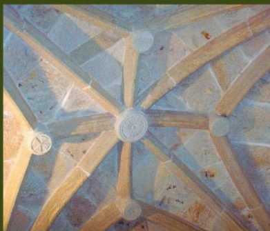
□ BÓVEDA DA ERMIDA DE SAN PAIO
